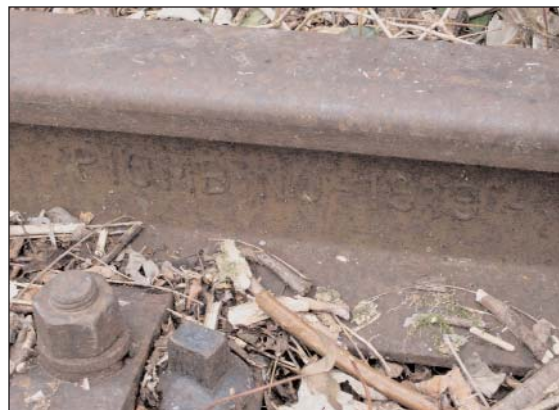
Un particolare del binario lungo la linea ferroviaria
